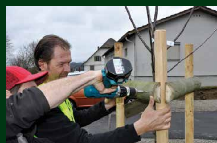
Den Hochstamm pflanzen und die Stützpfähle mit Verstrebungen anbringen.
