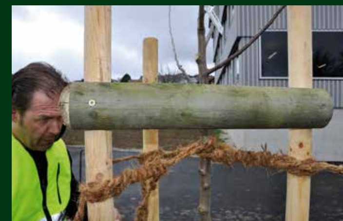
Den Stamm ausrichten und mit Kokosfaserschnüren befestigen.
