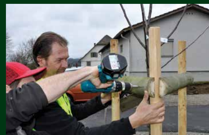
Den Hochstamm pflanzen und die Stützpfähle mit Verstrebungen anbringen.
