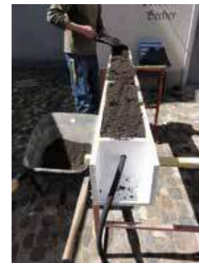
Auffüllen der Stützelemente mit Erde.
