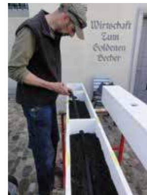
Einbetten des Perlschlauches in die Stützelemente.
