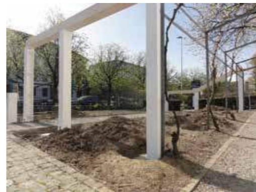
Montage der oberen Kanäle.
