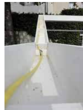
Einlegen des Verbindungschlauches für die Stützelemente.
