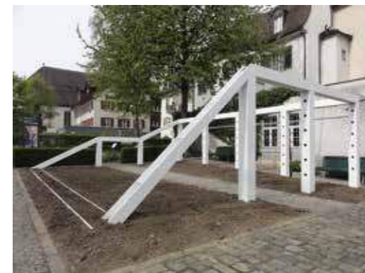
Die «Hochbeetbahn» ist im Rohbau fertig gestellt. Rasensaatgut wird auf die Beete ausgebracht.
