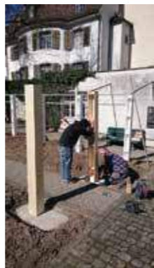
Anbringen der Befestigungsschuhe für die Stützen auf den Fundamenten.
