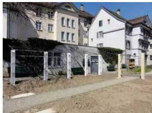
Ausrichten der Stütz-Elemente.
