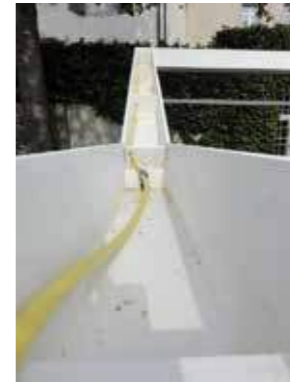
Einlegen des Verbindungschlauches für die Stützelemente.
