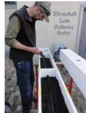
Einbetten des Perlschlauches in die Stützelemente.
