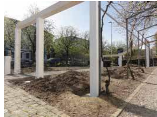
Montage der oberen Kanäle.
