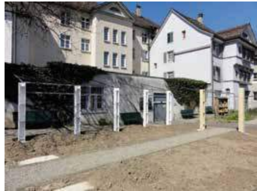
Ausrichten der Stütz-Elemente.
