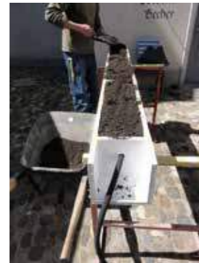
Auffüllen der Stützelemente mit Erde.
