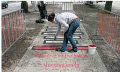
Deckschicht und Endfarbe auftragen
