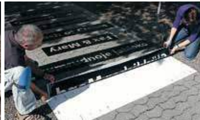
Aufbringen der Folie auf den Untergrund
